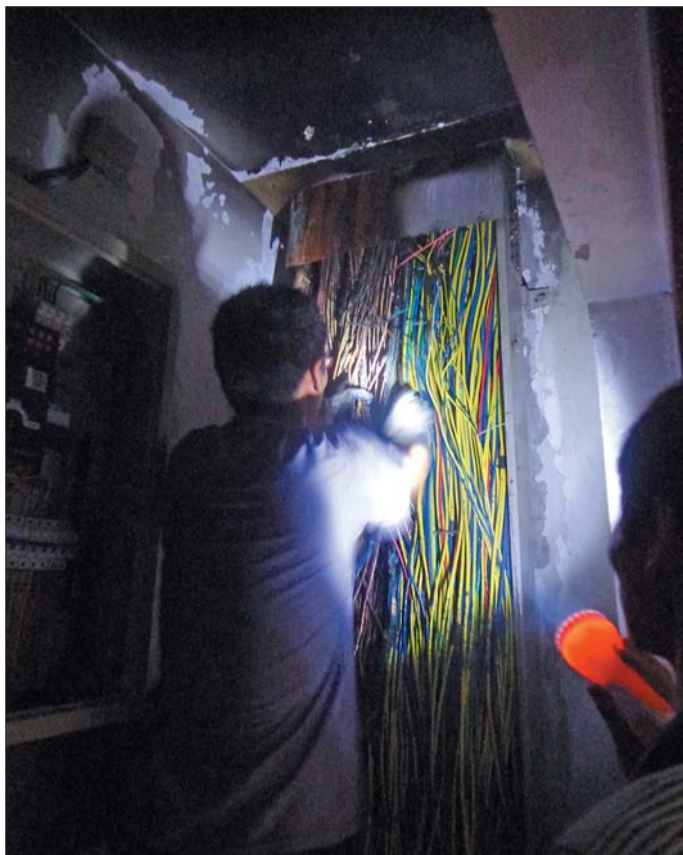
维修人员正在检修失火电井电线。 实习生 陈娇娇 摄
