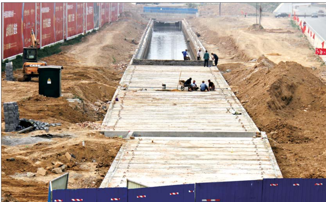
22日,三八路和东方红路沟段上,工人正在实施盖沟工作。本报记者 王小会 摄
