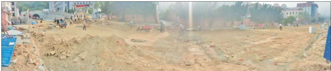
▲统一路(世昌大道—通海路)施工现场 通讯员 张悦 摄
