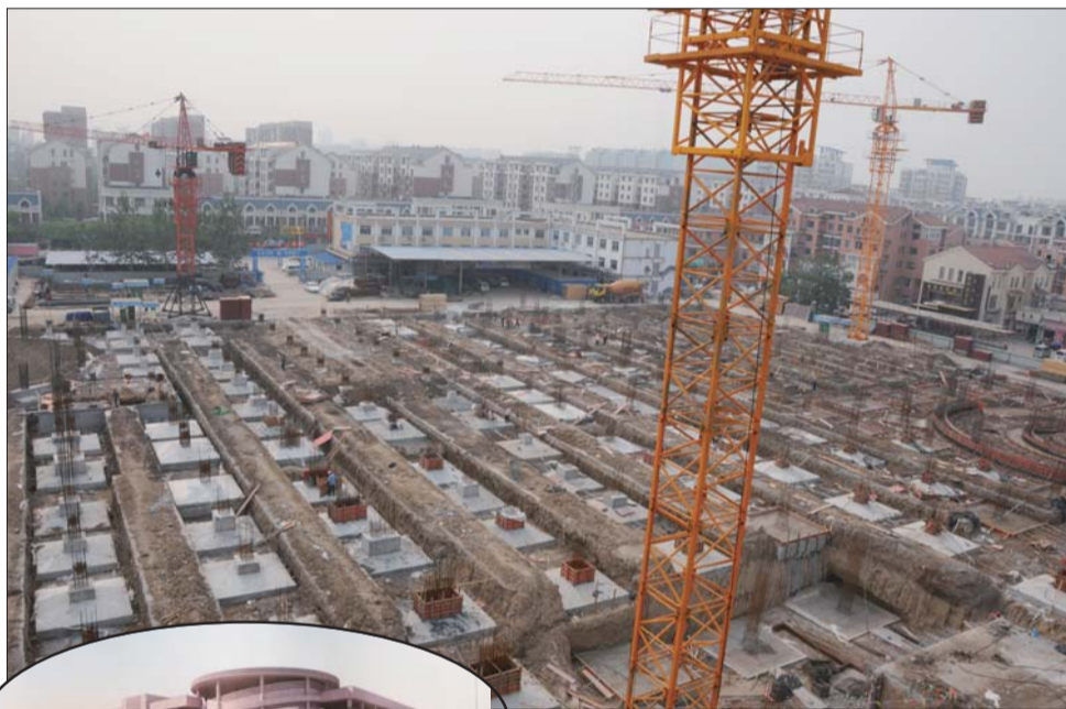
▲淄博首座独立停车楼施工现场。
