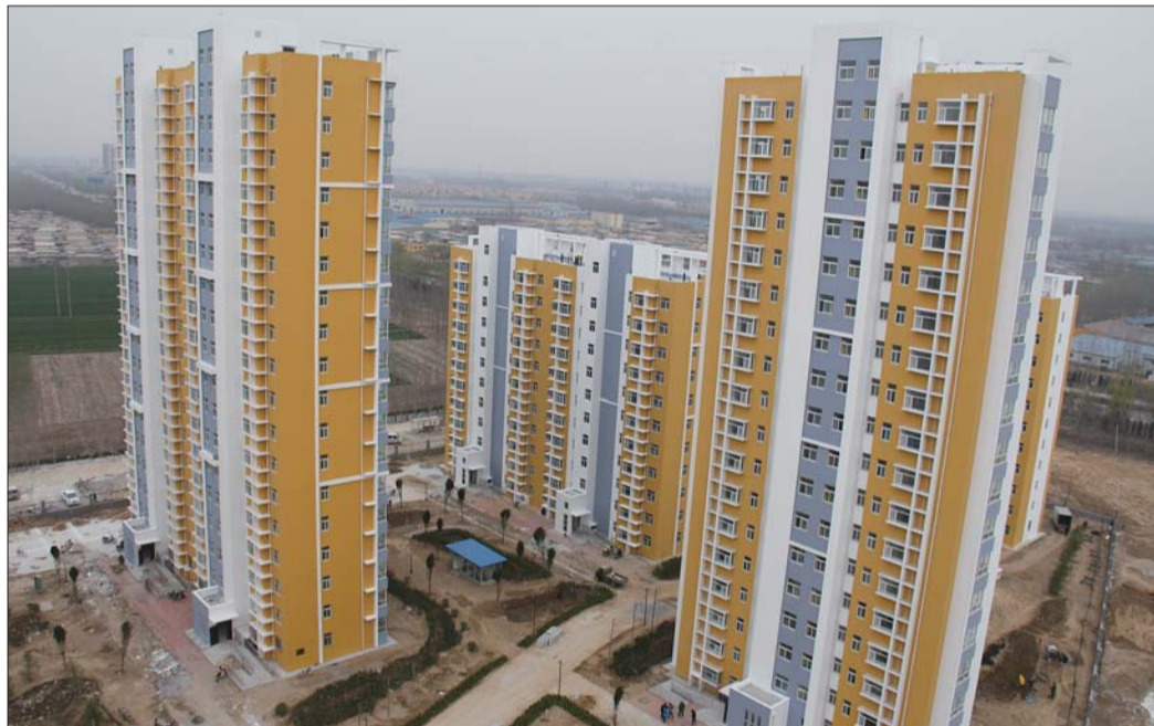
南湖新城项目一期16栋楼已经通过验收,7月份即可交房。
