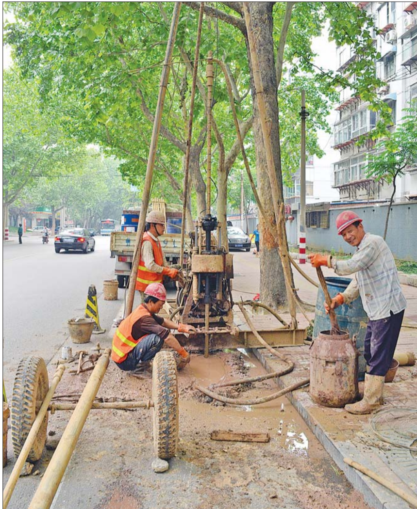
23日,勘探人员正在对和平路进行钻探施工。 本报记者 王光营 摄
