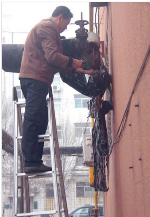
暖气管道维修或将由热力公司承担。(资料片) 本报记者 马志勇 摄
