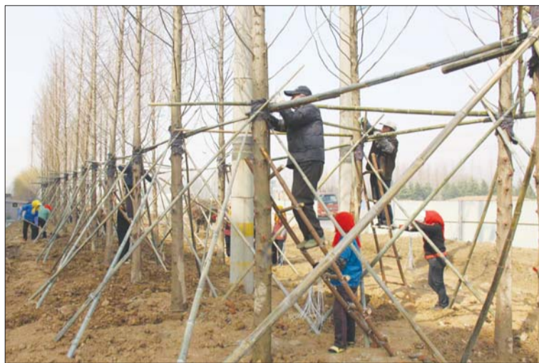
昆仑山路道路绿化施工现场。潘旭业 摄
