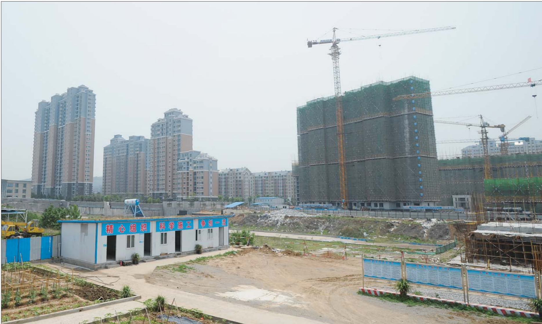
长清大学城附近的房地产项目十分密集,图为一房产项目工地。 本报记者 周青先 摄
