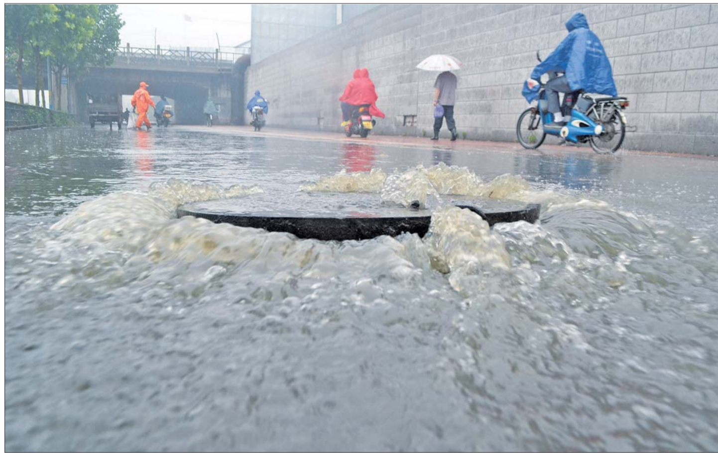
26日上午,历山路铁路桥北侧路西的自行车道中央一处下水道污水冒溢。
