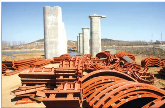
北珠岩跨绕城高速特大桥,跨河的桥墩已经拆下模板。未来,这里将变成青荣城铁的一部分。 记者 赵金阳 摄
