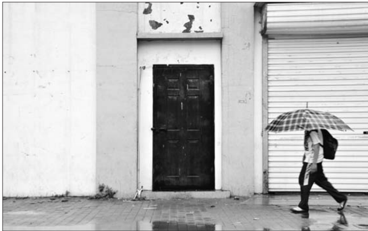
岔河小区内换热站。本报记者 王小会 摄
