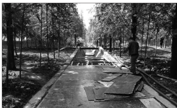
工作人员正在臭水沟上进行施工。
