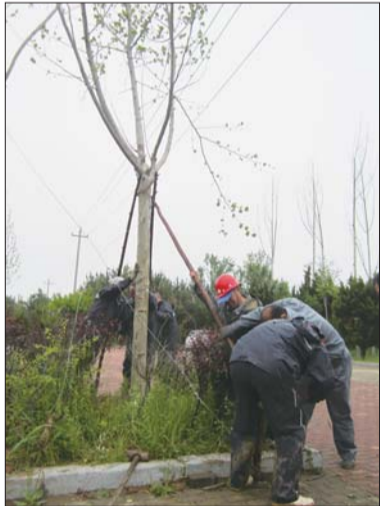
工作人员把现场“摔倒”的法桐扶起后重新加固。记者 侯艳艳 摄
