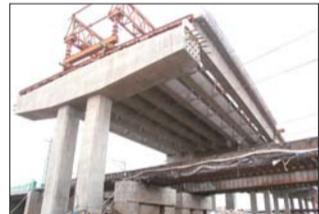
28日,二环西路高架桥工程完成跨京沪铁路最后一块箱梁吊装施工。至此,8片预制箱梁已全部吊装到指定位置。
