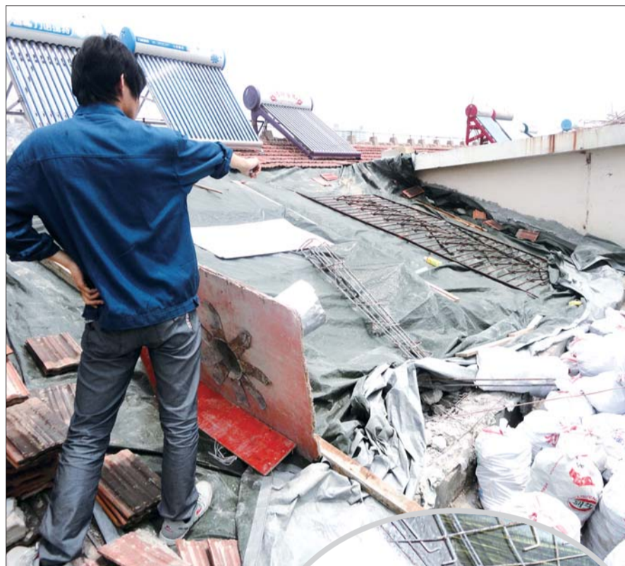
▲拆掉的房顶上盖着塑料布。
