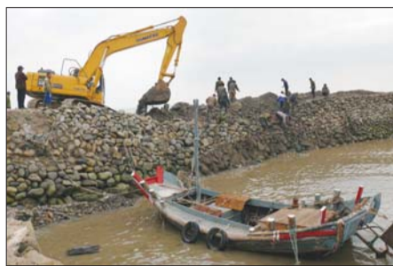
渔民正在修补被摧毁的堤坝。肖永军 摄
