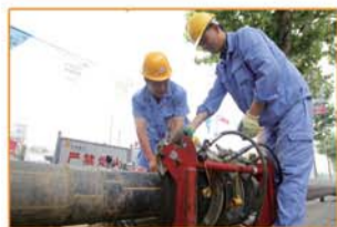
老旧管网改造
