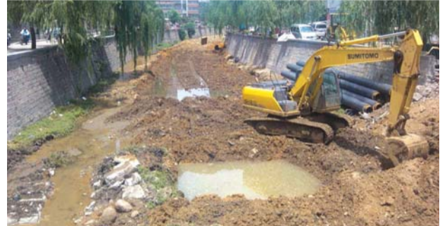
梳洗河中水流很小,有挖掘机在施工。本报记者 王世腾 摄
