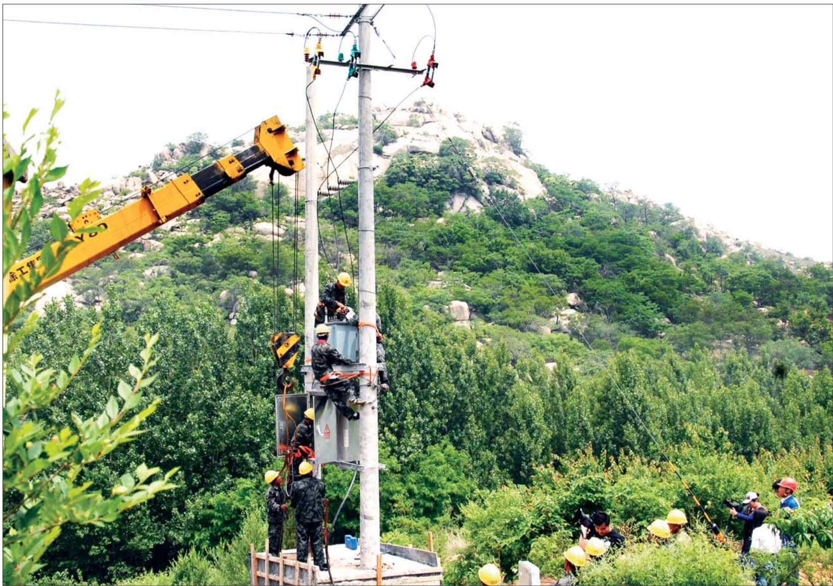
架设变压器。
