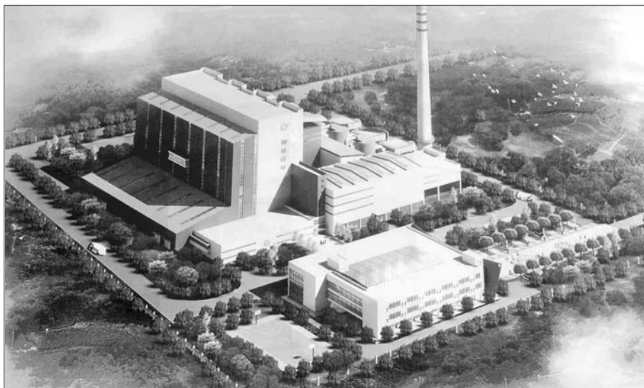
►生活垃圾焚烧发电厂鸟瞰图。
