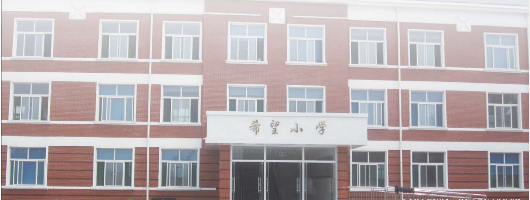
李庄镇东风悦达起亚希望小学新建的教学楼。
