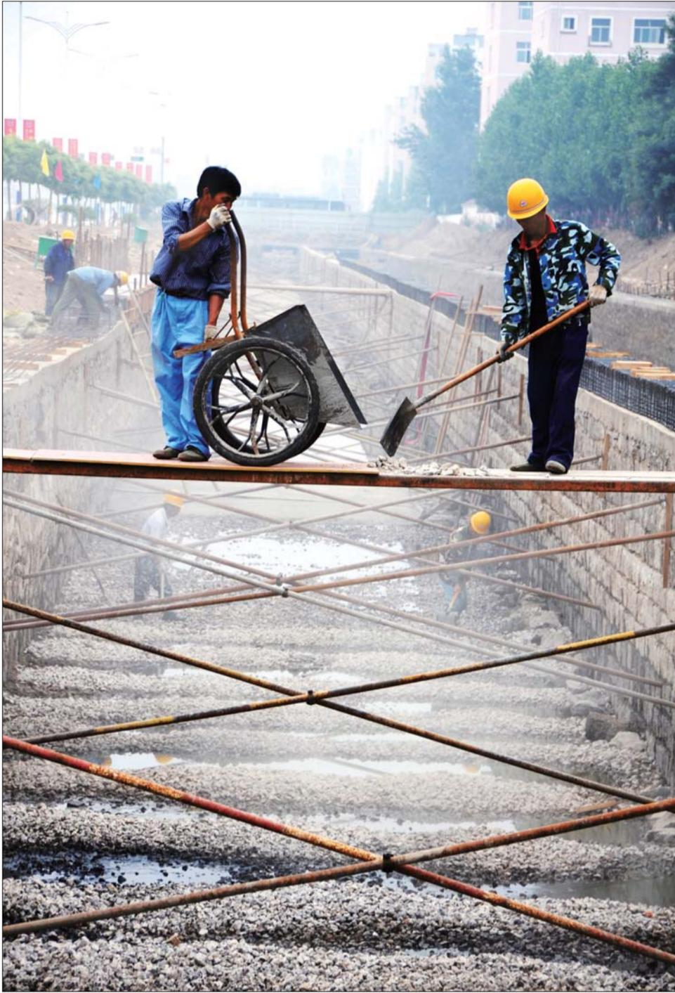
在简易板桥上倾倒施工石子。
