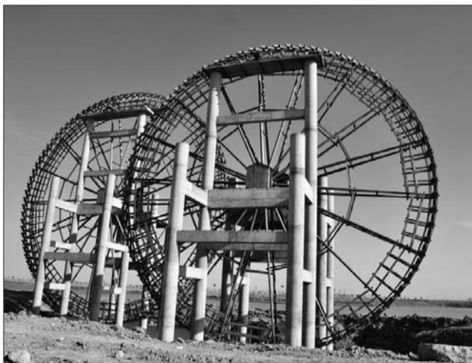
据北海经济开发区北海明珠湿地公园负责人林海介绍,两座水车中最大的水车直径22米,另一个直径18米,已投入建设资金200多万元。“整个水车选取纯木料,经工匠精雕细琢而成。水车的大轴、辐条、水斗、水槽等结构完全由柳楔组成,全部采用传统水车工艺制作,没有使用一枚铁钉。另外,水车用电实现转动,两座水车一小时提水量6吨左右。达到最高处的水像瀑布一样流下来,非常好看。”林海说。
