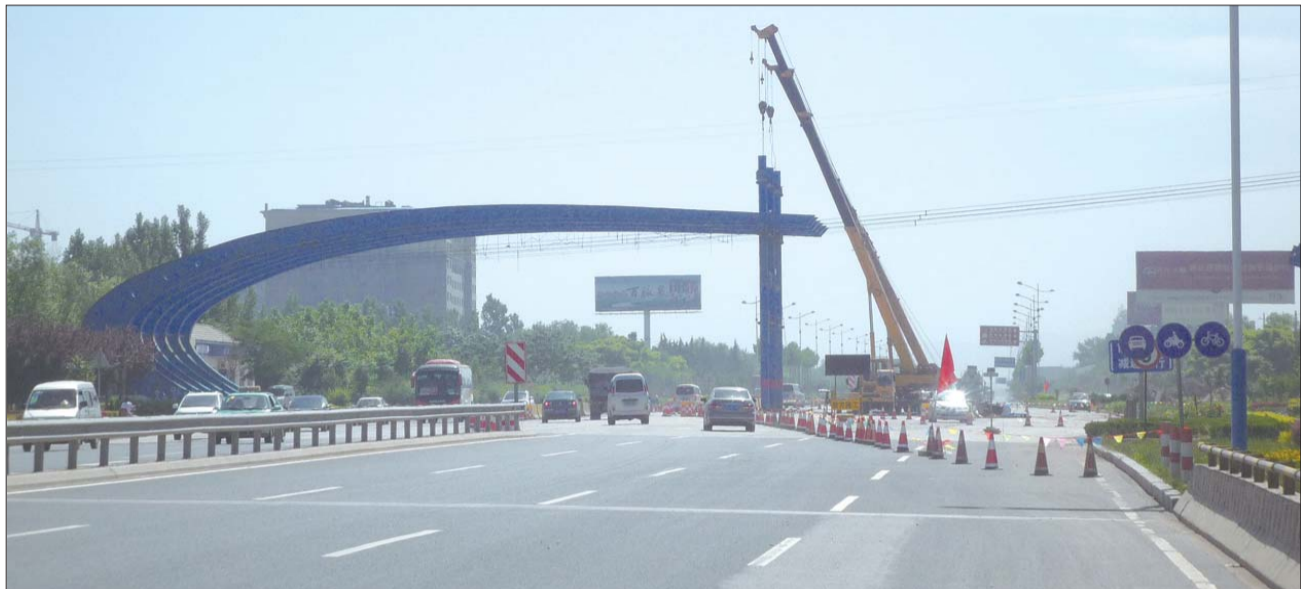
5月31日,正在拆除中的309国道圣井收费站(资料片)。 本报记者 朱頔 摄
