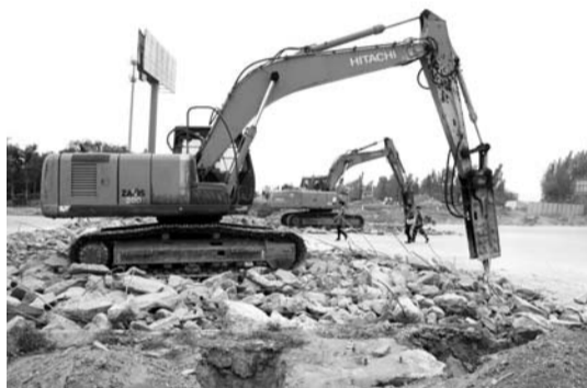
5日,105国道于官屯大桥已开始道路施工。
