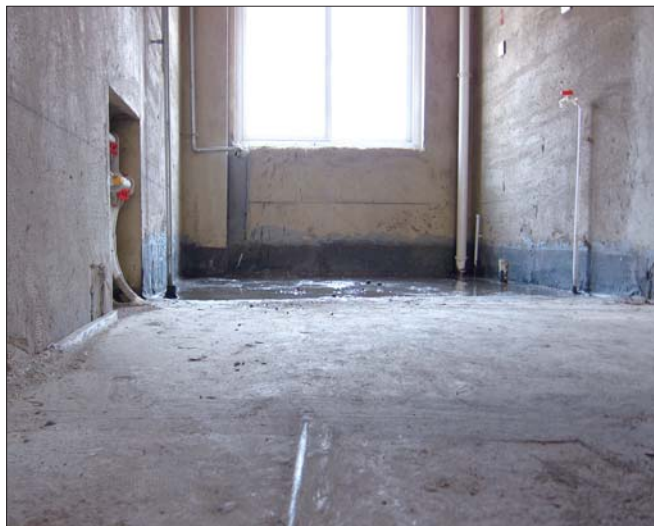
住户房屋内地面上裸露在外的地暖管。 本报记者 孙婷婷 摄
