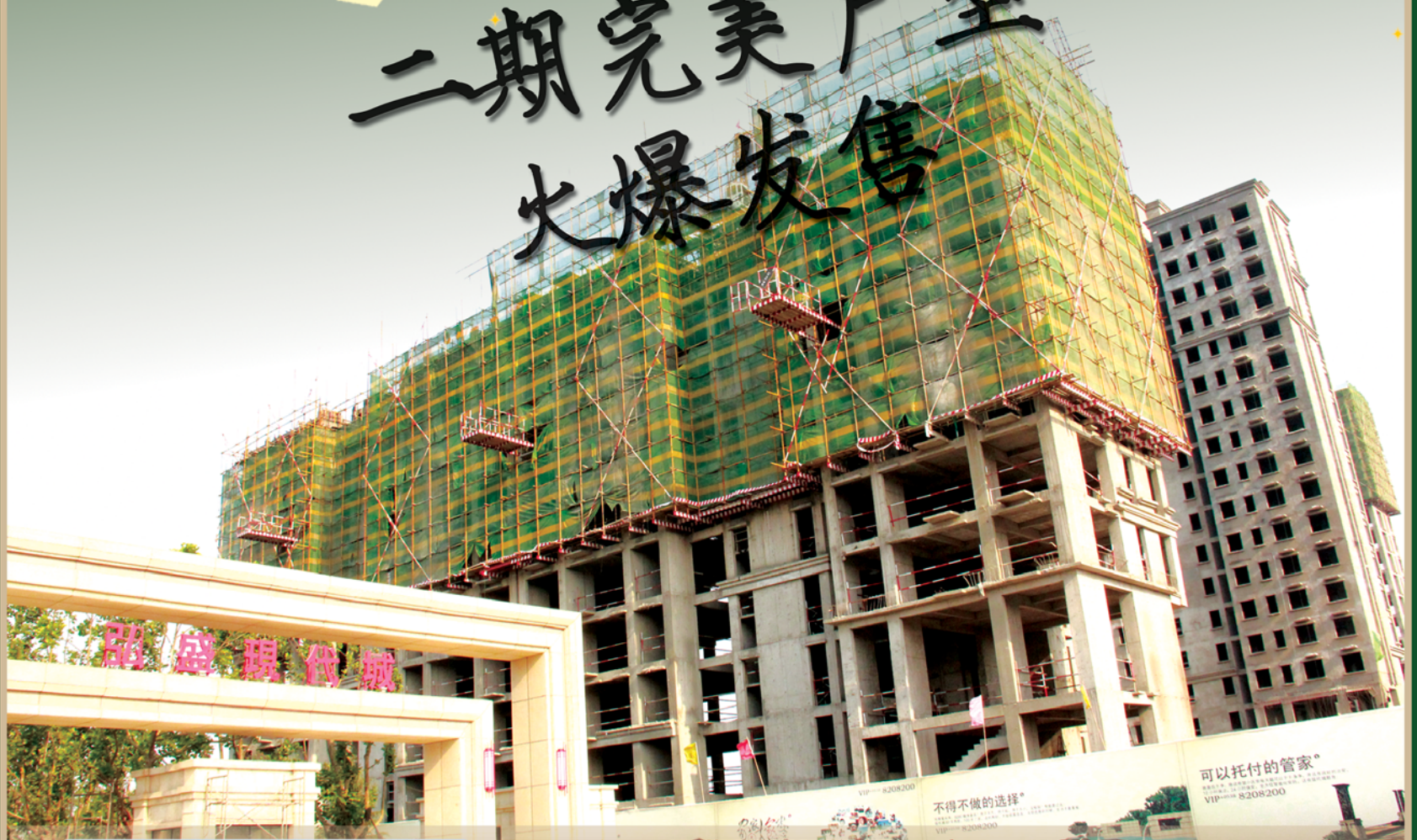
本版照片均为实景照片
