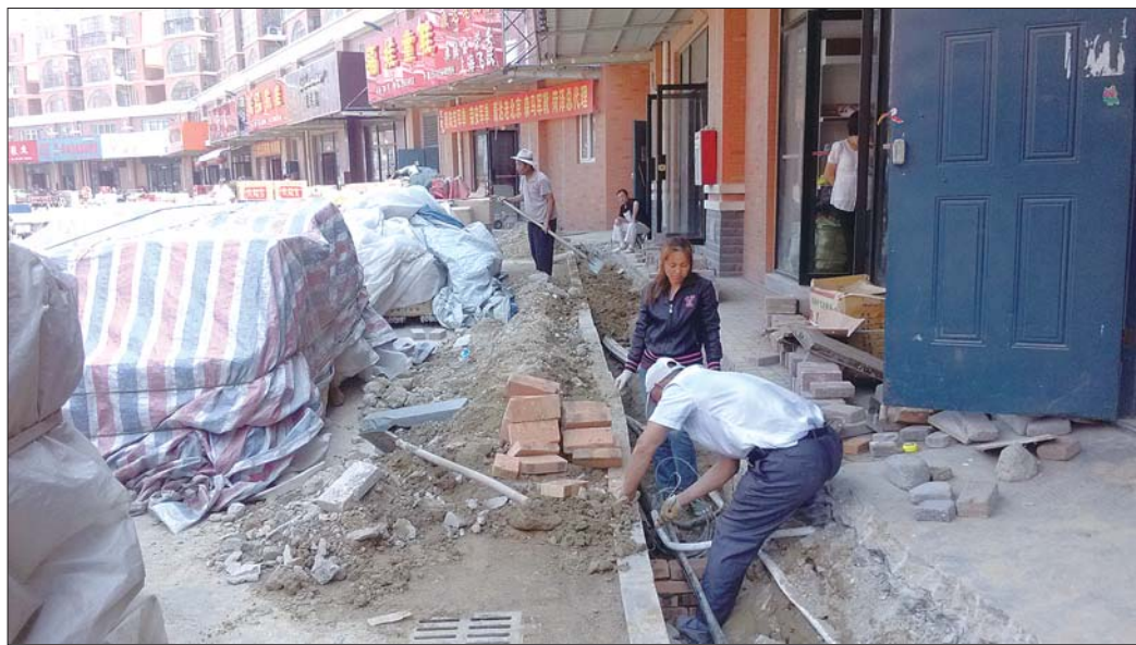
▲12日上午,工作人员将刚刚换过的地下电缆埋起来。
