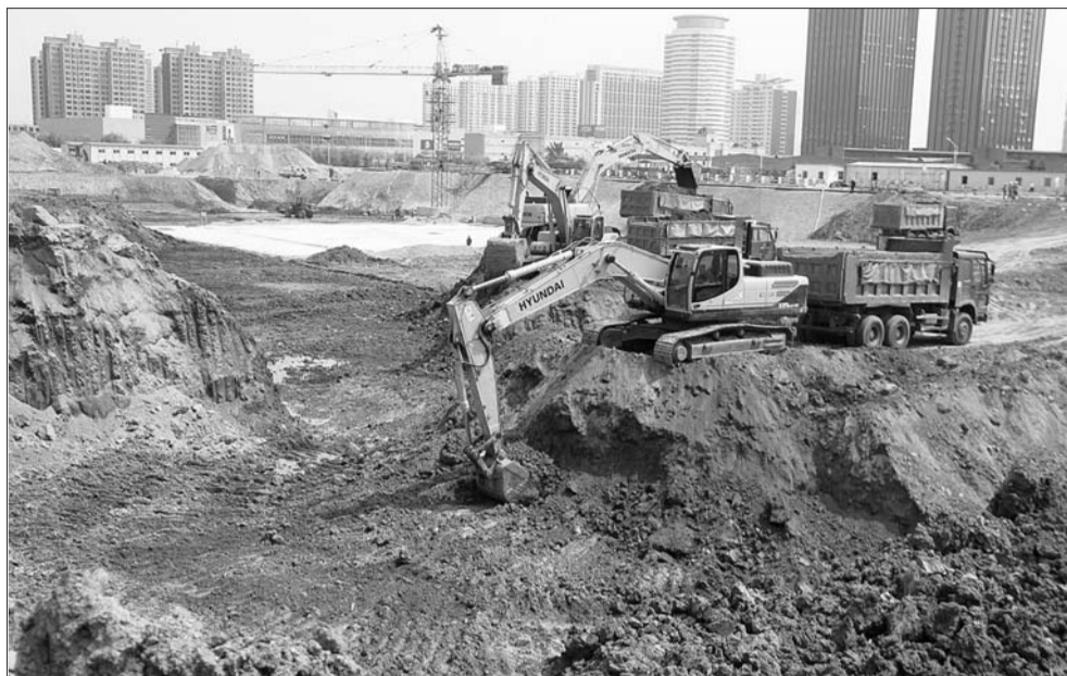
▲13日,威海站施工现场。记者 王震 摄。
