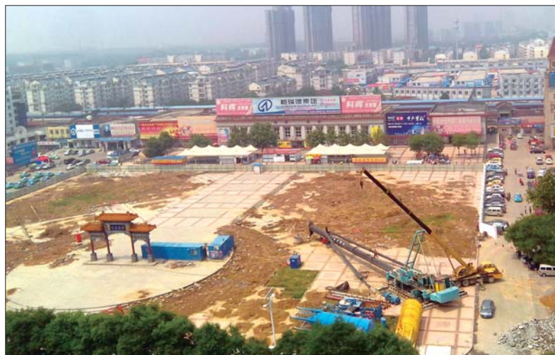
19日,德州火车站及车站广场改造工作现场。 郭光普 摄
