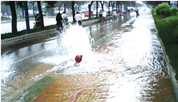
消防栓被撞断后,人行道、非机动车道上都是水。(热心市民供图)
