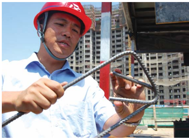
梁海涛说,为了达到7度抗震钢筋等建材的用量比其他楼盘多不少。
