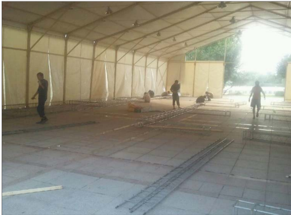
▲工作人员正在现场搭建展览会场。 晋兆峰 摄
