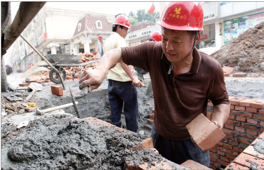
▲马福廷头顶烈日修砌步行街一处阀门井。
