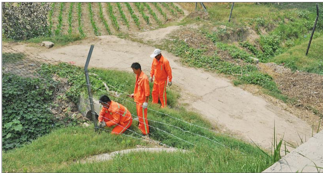
养护人员在修补被破坏的高速公路防护网。
