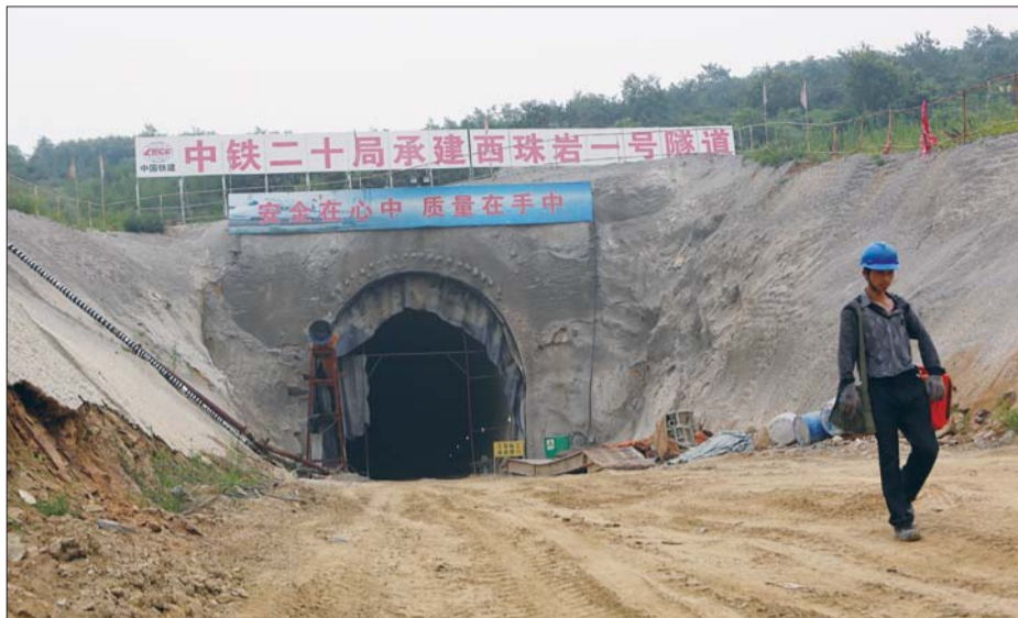
施工工人从西珠岩1号隧道洞口走出。记者 孙健 摄
