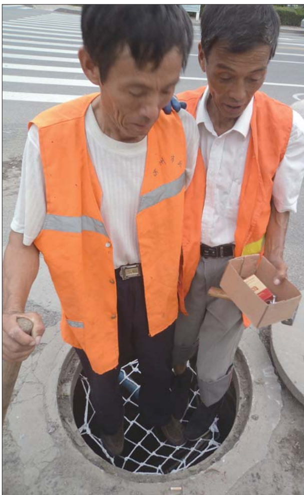
两个工作人员站在防坠网上面很安全。 本报记者 王丽丽 摄
