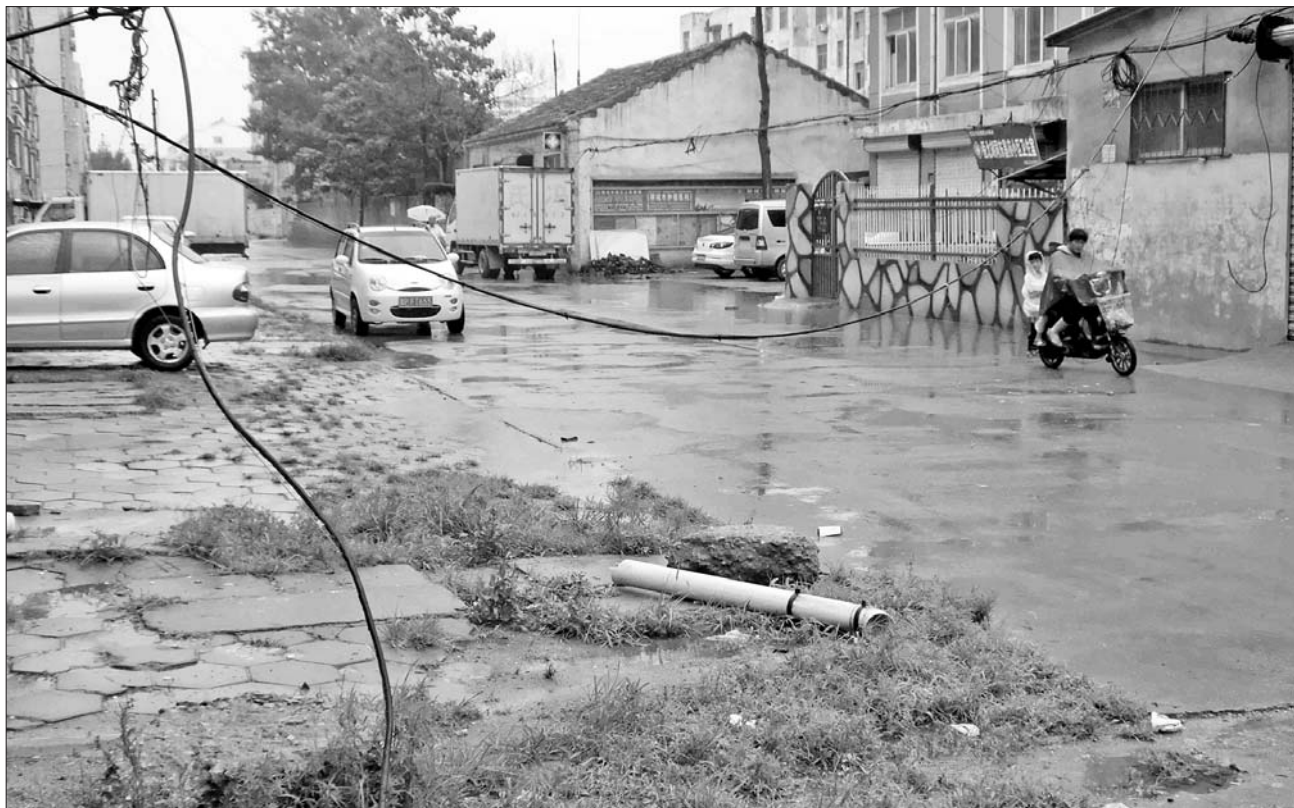
电缆最低处距地面不到1米,市民只能从南侧缝隙通过。 本报记者 郭庆文 摄
