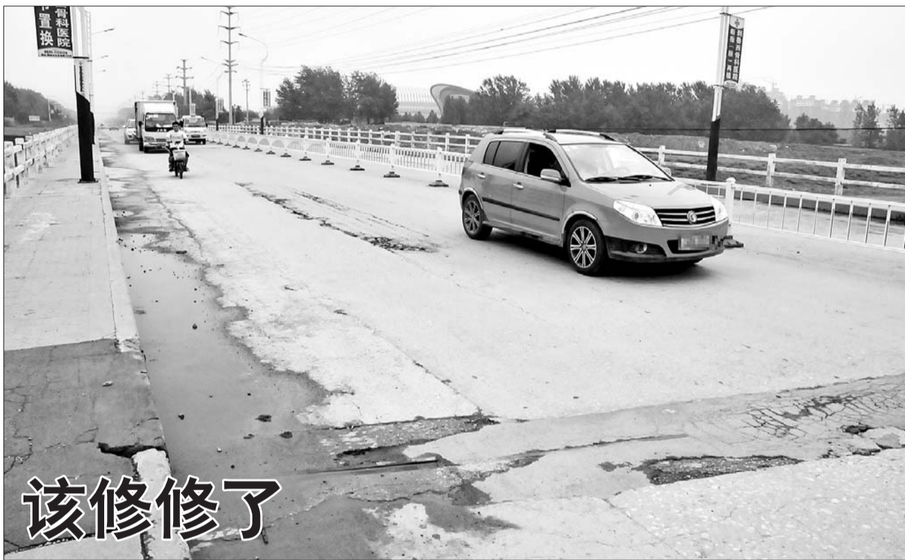
城区湖南路徒骇河大桥部分桥面受损严重,有的甚至裸露出钢筋,公交车从此经过时桥面都会颤抖。图为9日,湖南路徒骇河大桥上来往的车辆。 本报记者 邹俊美 摄
