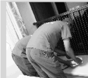
①安装人员在用户家中安装电表
