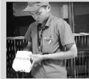
③安装人员对电表进行封条处理
