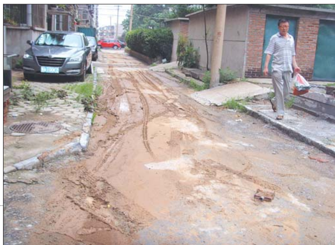
►在英雄山路92号院东面的七里山下,从山体上流下来大量泥沙,覆盖了小区道路。 本报记者 赵伟 摄
