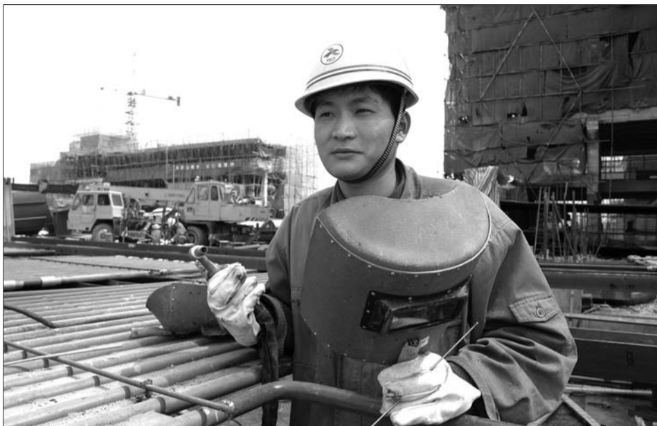
刘治强在施工现场。
