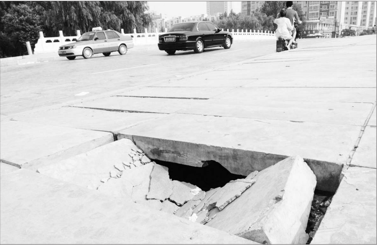
运河桥桥面石板发生断裂下陷。 本报记者 李璇 摄
