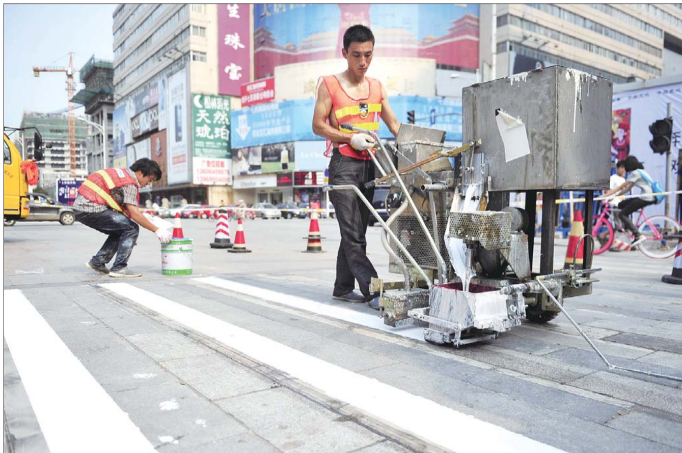
10日,在济南泉城路上,交通局的施工人员正在院前街路口画斑马线。 本报记者 王媛 摄
