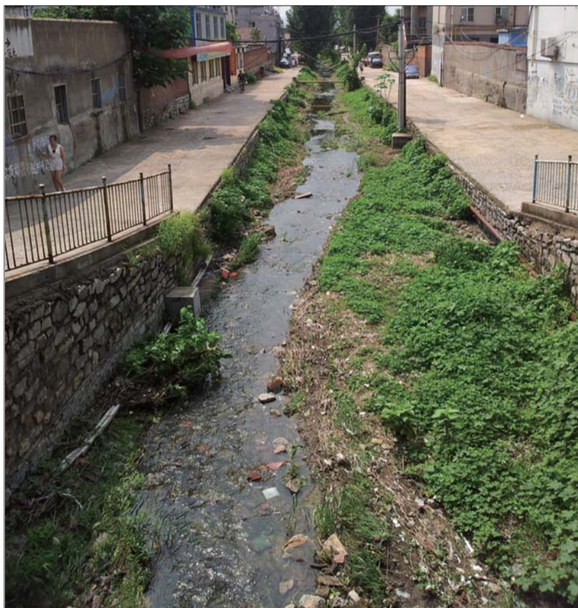
▲臭水沟流过居民区。
