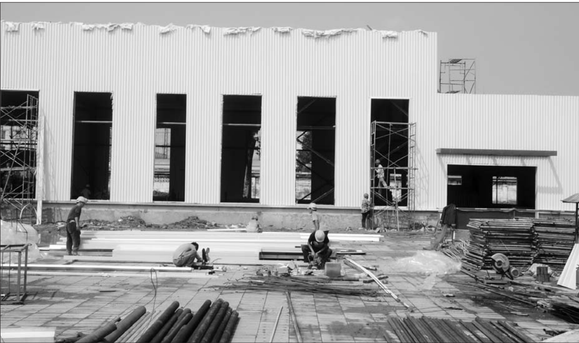
13日,德州火车站临时站房施工现场,外墙主体结构已经接近完工,随后将进行内部装修。 本报记者 马志勇 摄
