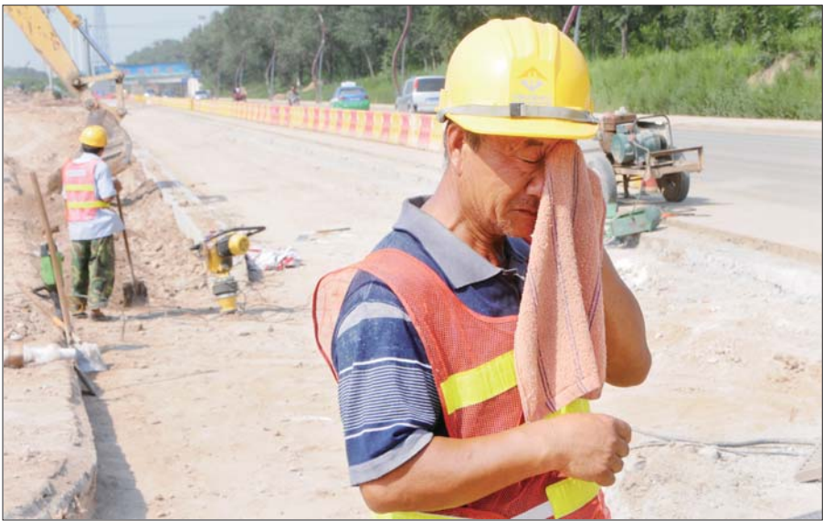
13日中午,在滨河路旁的施工人员,不停地擦拭脸上的汗水。 本报记者 马志勇 摄
