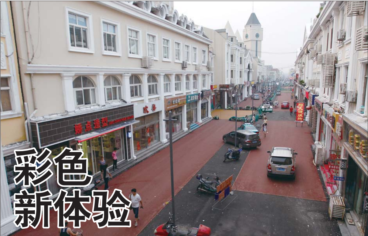
13日下午，张店新世界商业步行街彩色沥青路面基本铺设完成。路段北起共青团西路，南到商场西街，长度约260米，总面积约4000平方米。路面大部分为红色，中间有两段黄色。市民现场体验反映，彩色沥青路面观感和脚感都不错。 本报记者 王鑫 摄影报道
