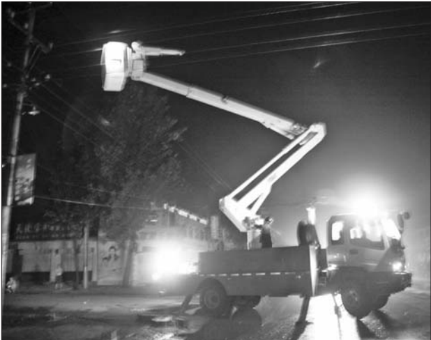
12日凌晨，电力抢修人员连夜开展紧急抢修。
